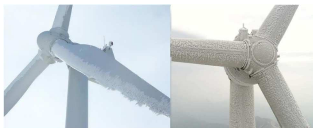
Figura 1.15. Depuneri de gheață pe palele elicelor eoliene (adaptată după [88])
